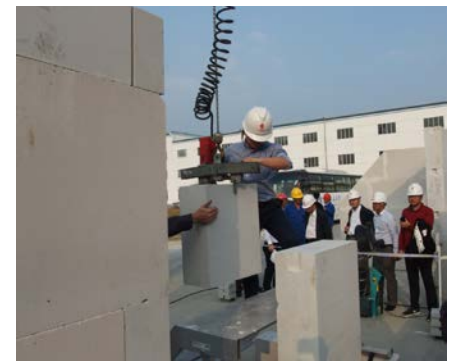
Bei einer Wandbaustellen-Vorführung wurde die herausragende Effizienz im Mauerwerksbau mit Planelementen und Passsteinen erlebbar.
